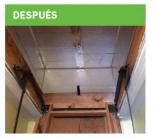
Las escaleras desplegables del ático deben estar selladas y aisladas de forma segura y duradera para evitar el movimiento del aire y reducir la transferencia de calor.
