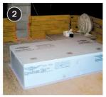
Aísle la parte superior y los lados de la cubierta de la represa, de acuerdo con el valor R correspondiente. Utilice materiales que cumplan con los requisitos del código de seguridad contra incendios aplicable (p. ej., barreras térmicas o de ignición).
