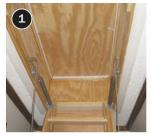
Construya una cubierta por encima y alrededor de la escalera desplegable, más alta que la altura final del aislamiento.
